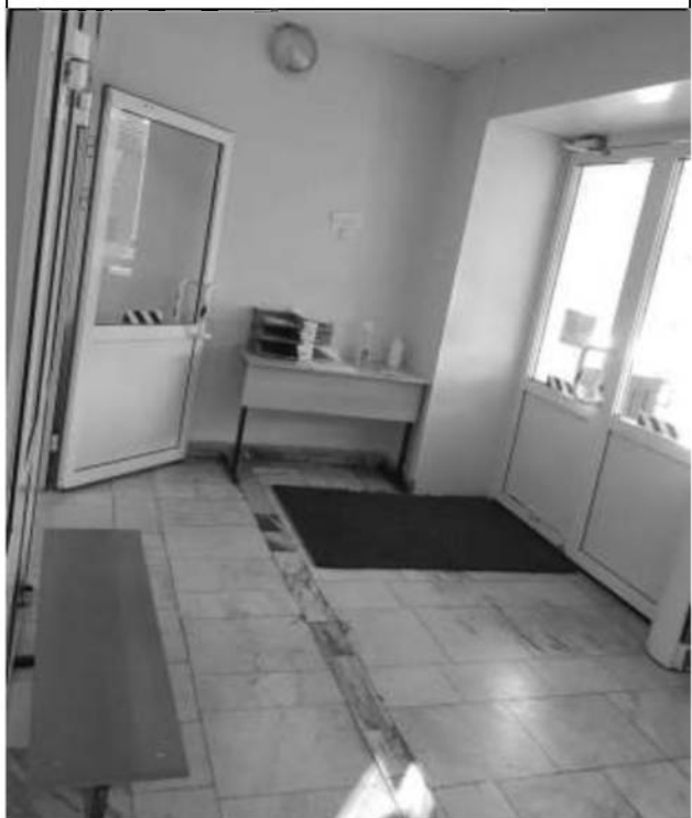
Фото 15 – Вход в здание (тамбур)
