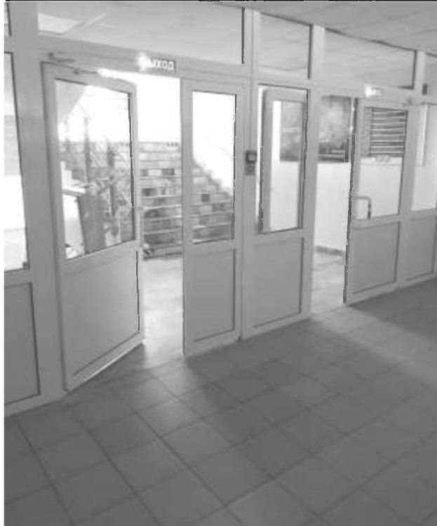
Фото 44 – Вход на этаж
