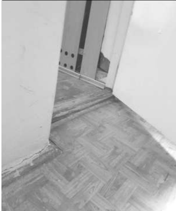
Фото 28 – Запасной выход из актового зала
