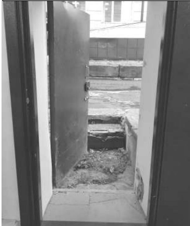
Фото 40 – Запасной выход из спортзала
