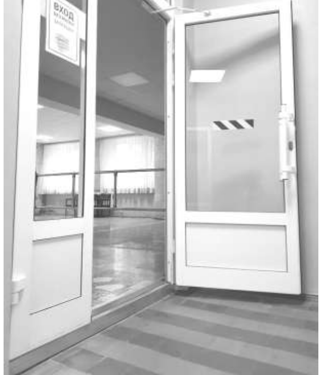
Фото 12 – Вход в здание
