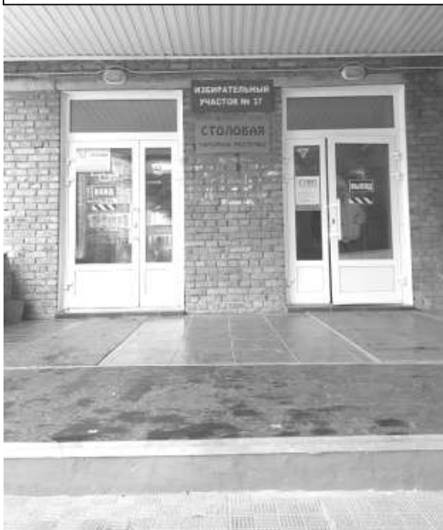
Фото 5 – Вход в здание
