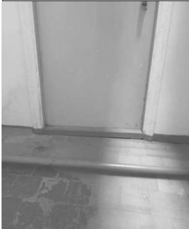
Фото 32 – Запасной выход из актового зала
