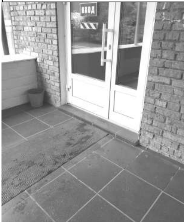
Фото 6 – Вход в здание
