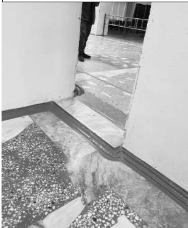
Фото 34 – Путь движения внутри здания
