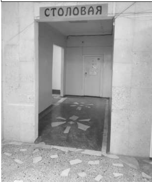
Фото 65 – Вход на II этаж
