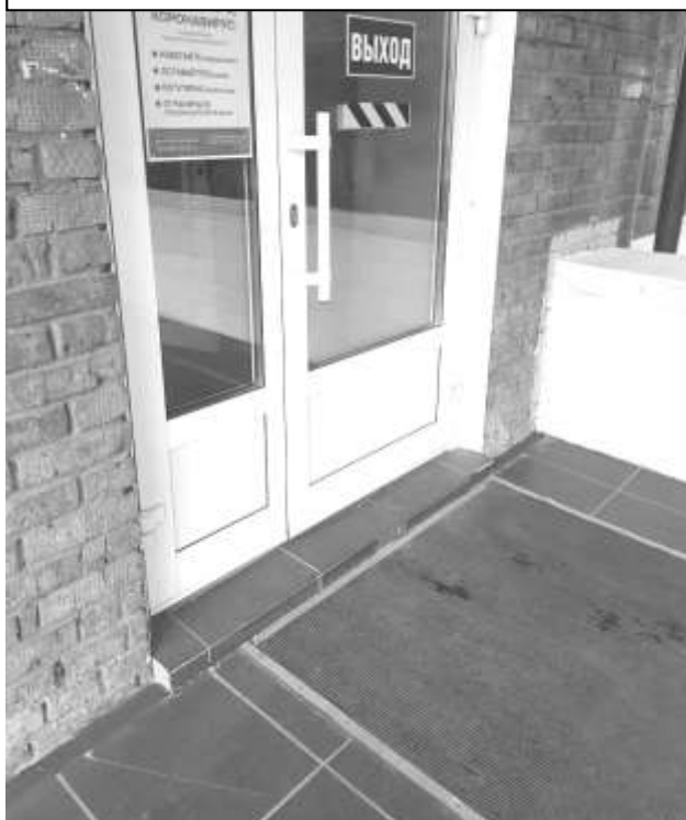
Фото 7 – Вход в здание
