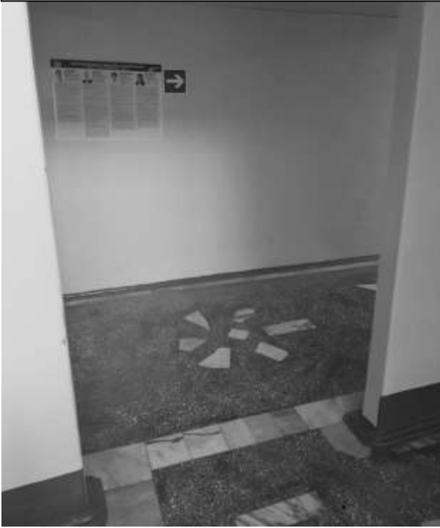
Фото 77 – Выход на I этаж
