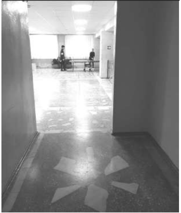
Фото 78 – Выход на I этаж
