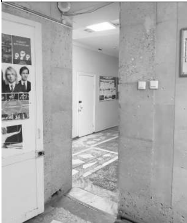
Фото 33 – Путь движения внутри здания
