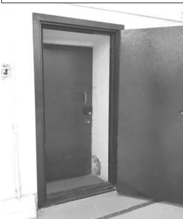
Фото 39 – Запасной выход из спортзала
