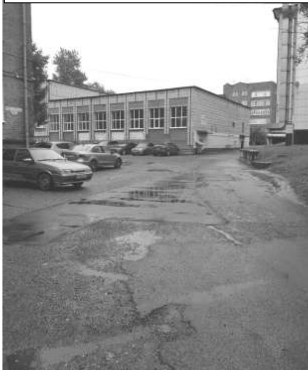
Фото 2 – Путь от парковки до входа
