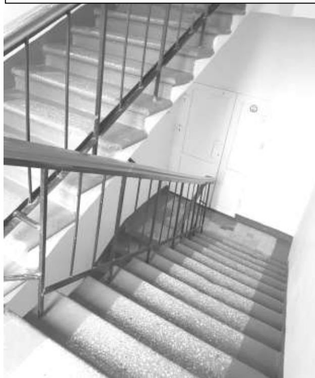
Фото 46 – Лестница на II этаж
