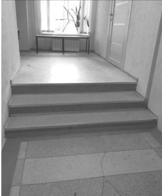
Фото 32 – Путь движения внутри здания
