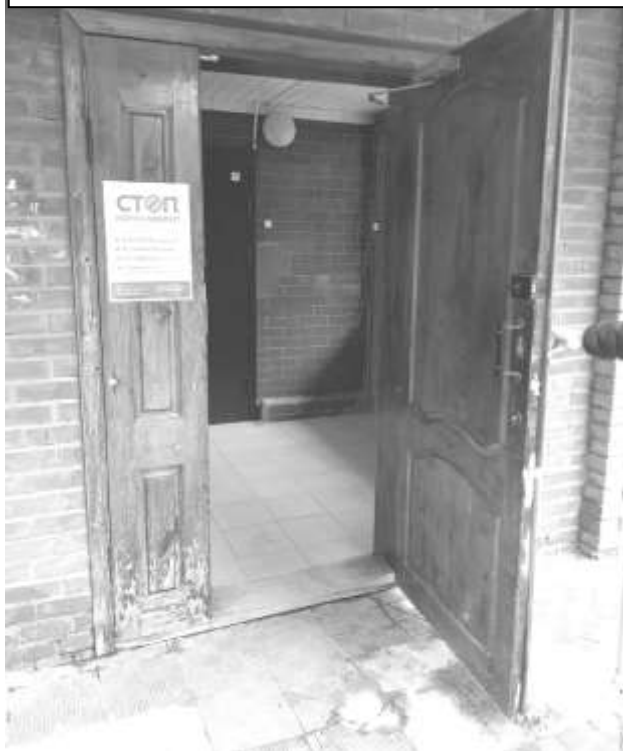
Фото 8 – Вход в здание (наружная дверь), тамбур
