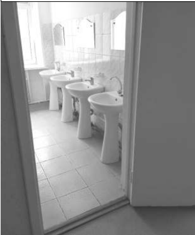
Фото 59 – Умывальная комната. Вход в душевую комнату.
