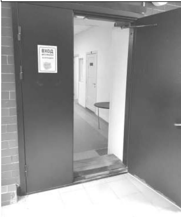
Фото 9 – Вход в здание (внутренняя дверь)
