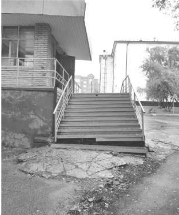
Фото 4 – Вход в здание
