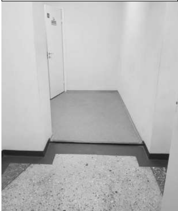
Фото 15 – Путь движения внутри здания
