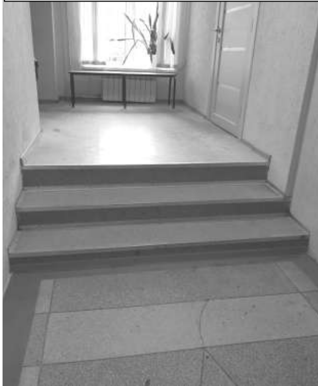
Фото 32 – Путь движения внутри здания
