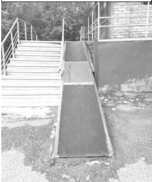
Фото 7 – Вход в здание
