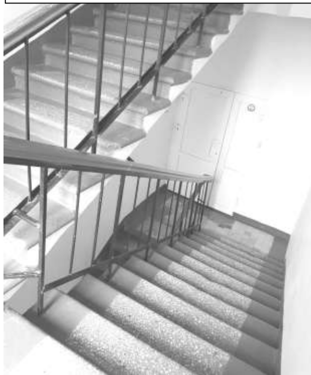
Фото 46 – Лестница на II этаж
