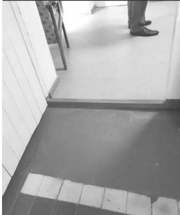
Фото 48 – Вход на II этаж
