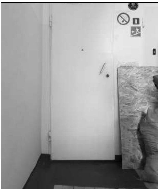
Фото 47 – Вход на II этаж
