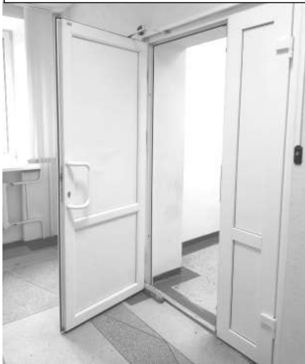
Фото 14 – Путь движения внутри здания
