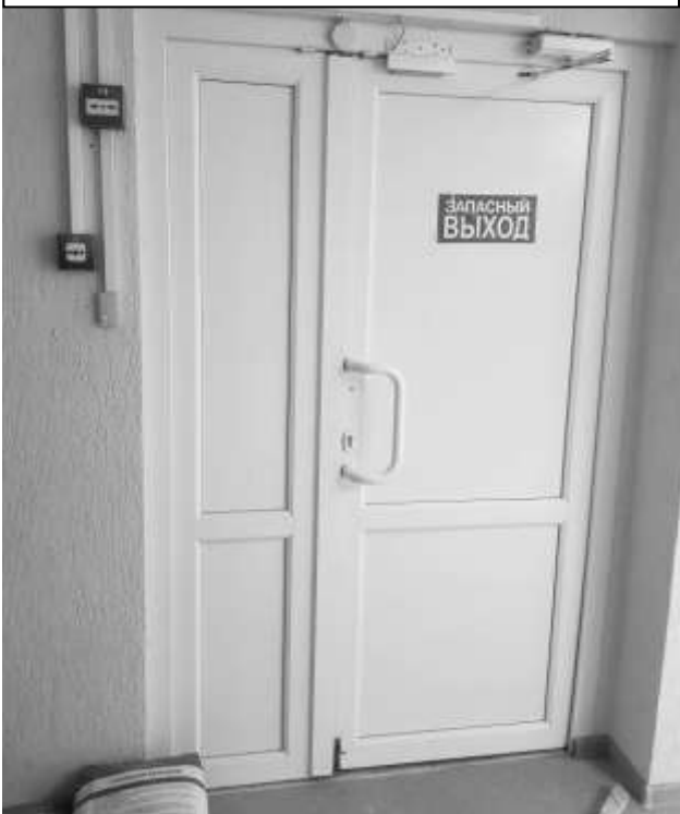
Фото 39 – Эвакуационный выход. Вход на II этаж
