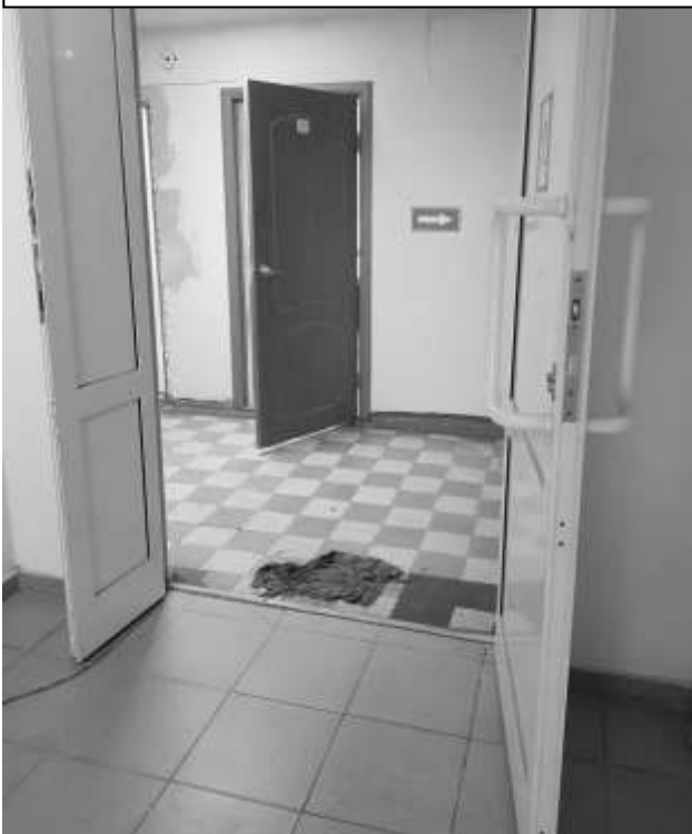
Фото 55 – Вход на этаж
