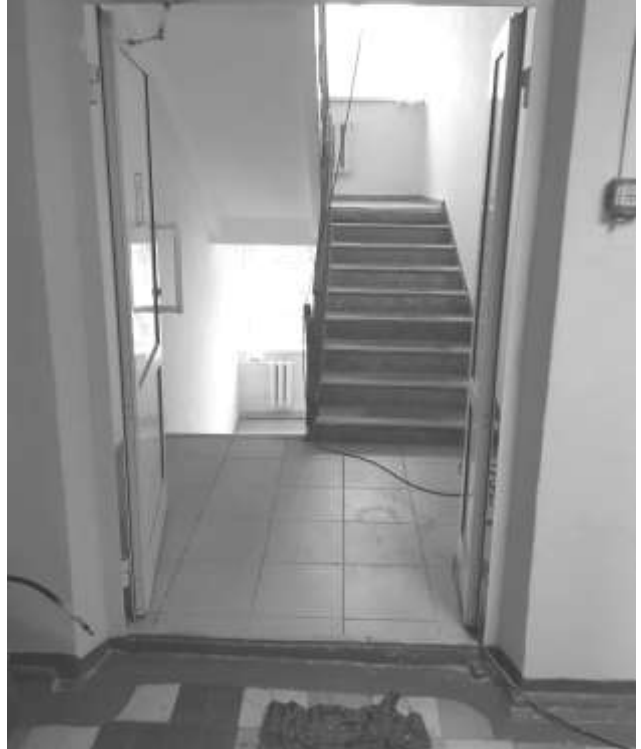
Фото 56 – Выход на лестницу
