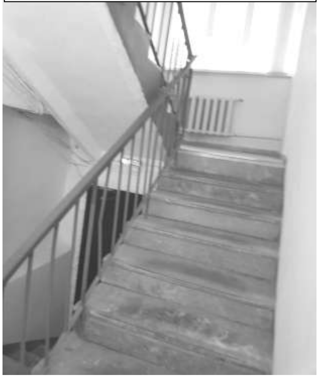
Фото38 – Лестница на верхние этажи
