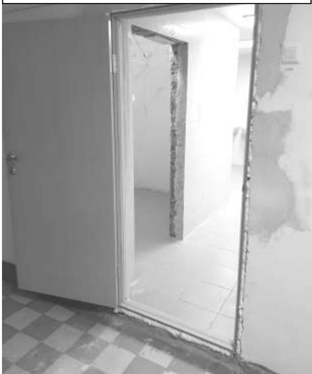
Фото 59 – Умывальная комната с душевой IV этаж
