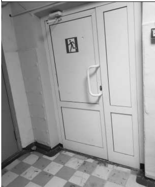
Фото 31 – Вход на верхние этаж Эвакуационный выход
