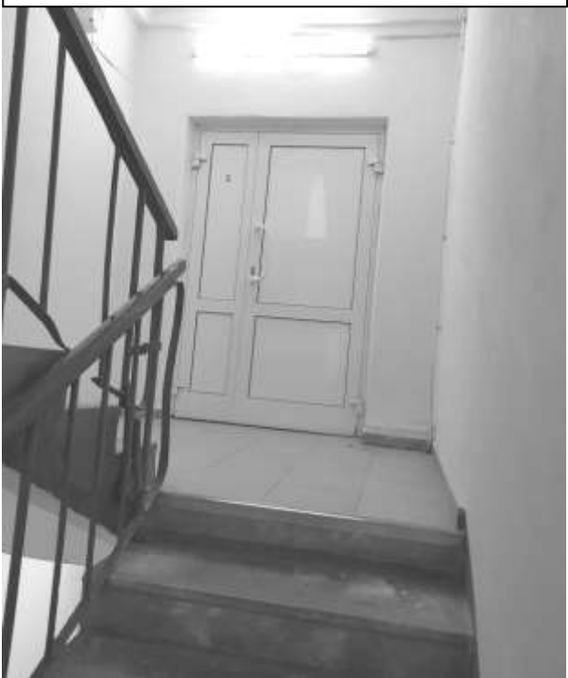
Фото 39 – Вход на Пэтаж
