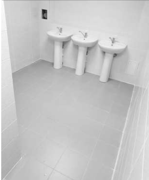
Фото 60 – Умывальная комната с душевой IV этаж
