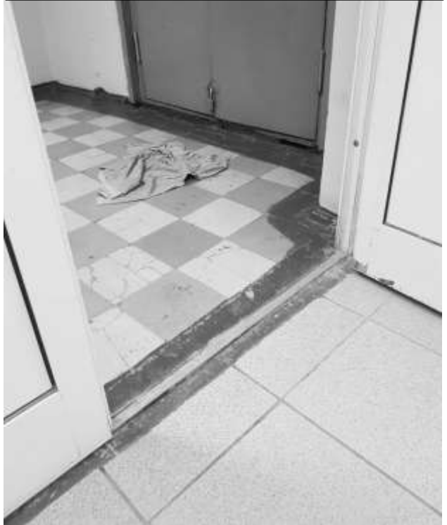
Фото 40 – Вход на Пэтаж
