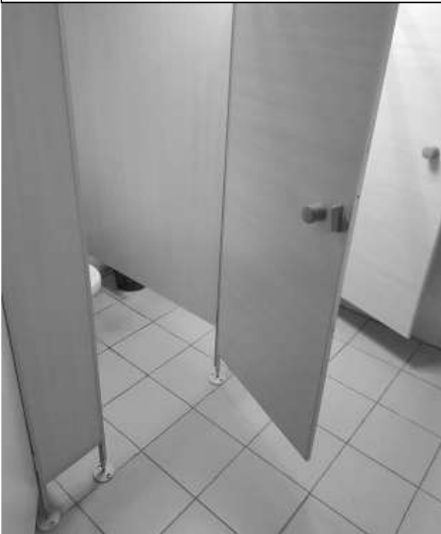
Фото 53 – Санузел II этаж
