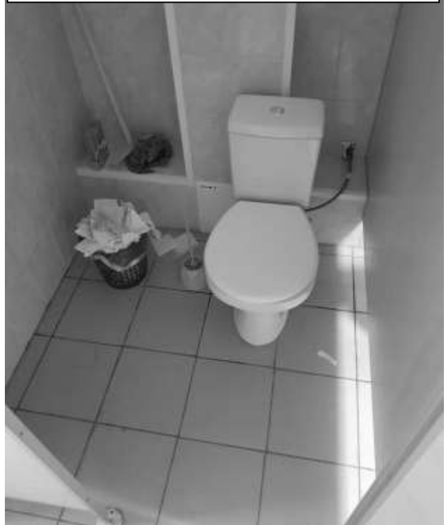
Фото 54 – Санузел II этаж
