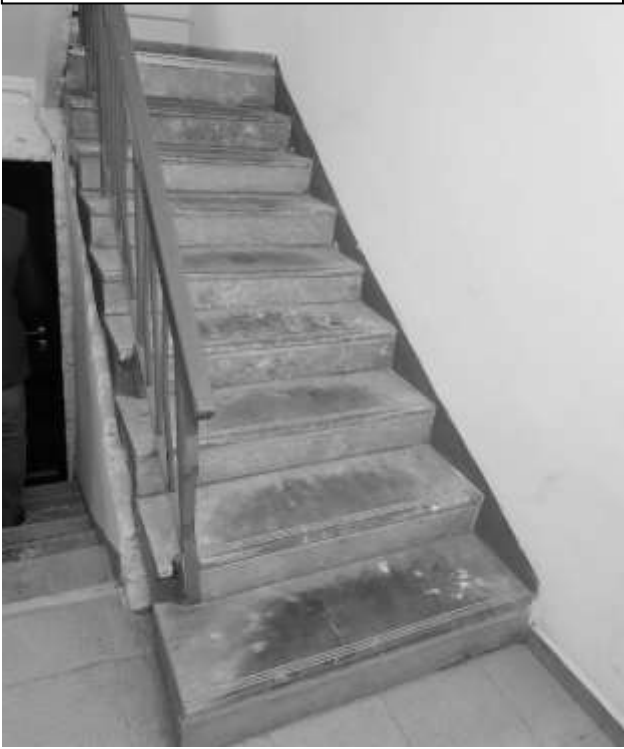
Фото 37 – Лестница на верхние этажи
