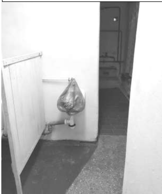
Фото 30 – Санузел I этаж
