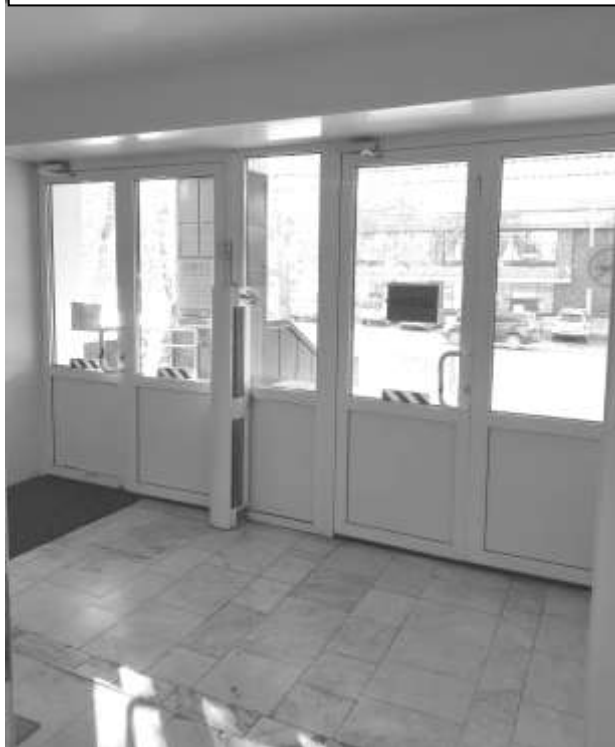
Фото 14 – Вход в здание (тамбур)
