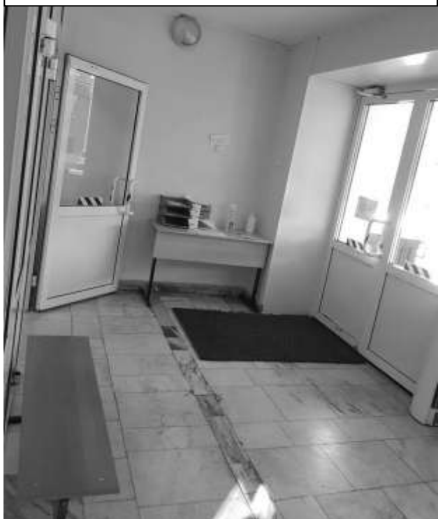
Фото 15 – Вход в здание (тамбур)
