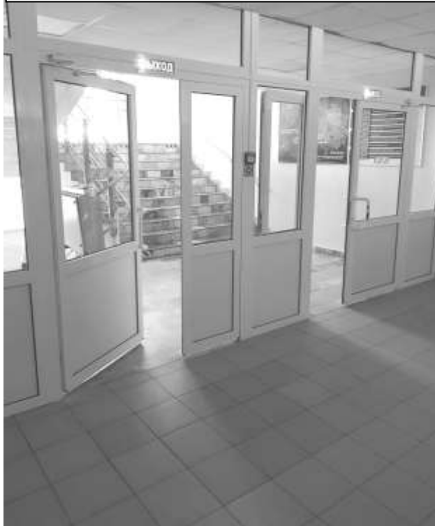
Фото 44 – Вход на этаж
