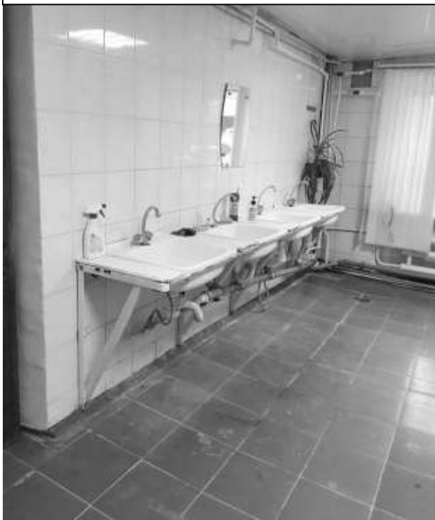
Фото 25 – Умывальники I этаж
