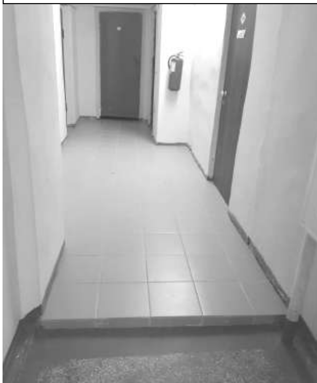
Фото 67 – Коридор IV этаж
