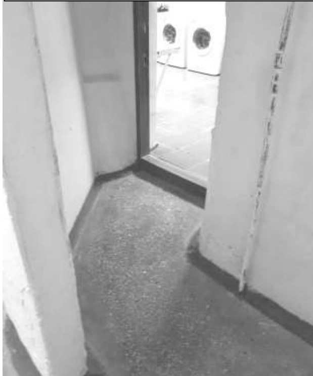
Фото 28 – Вход в санузел из умывальников I этаж
