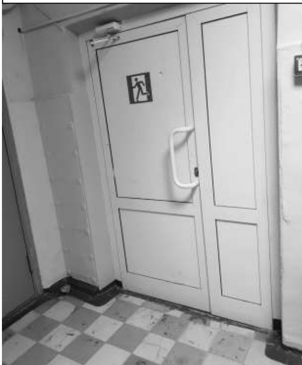
Фото 31 – Вход на верхние этаж Эвакуационный выход
