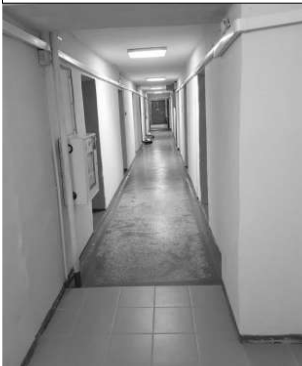
Фото 65 – Коридор IV этаж
