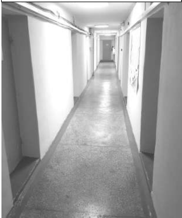
Фото 49 – Коридор II этаж
