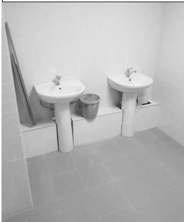
Фото 62 – Санузел IV этаж
