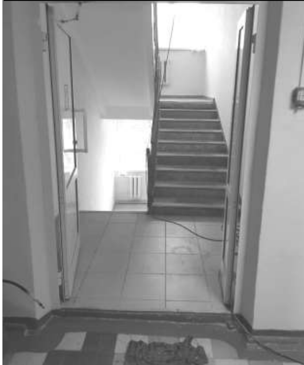
Фото 56 – Выход на лестницу
