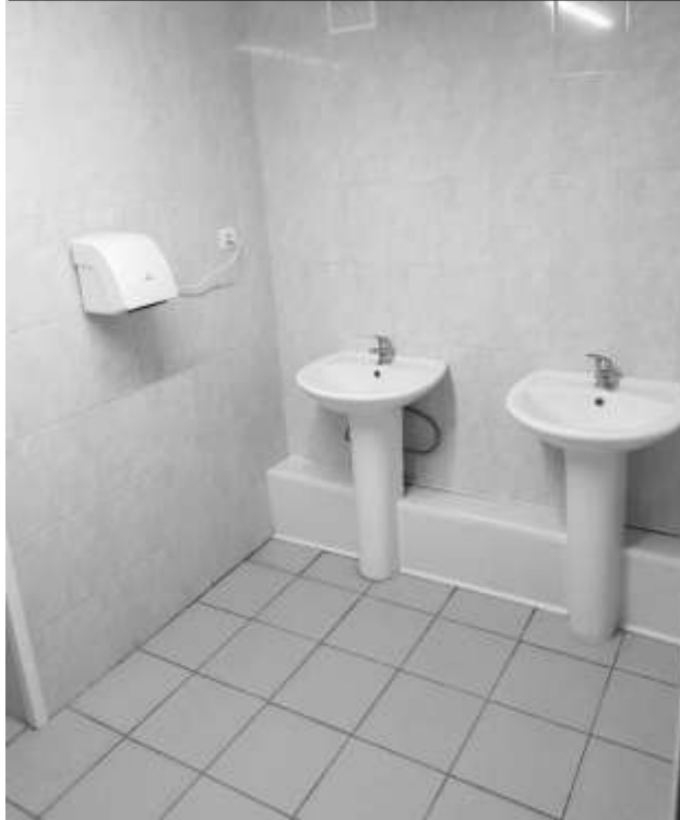
Фото 52 – Санузел II этаж
