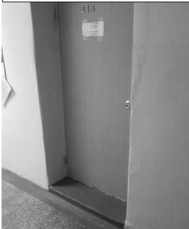
Фото 50 – Дверные проемы II этаж
