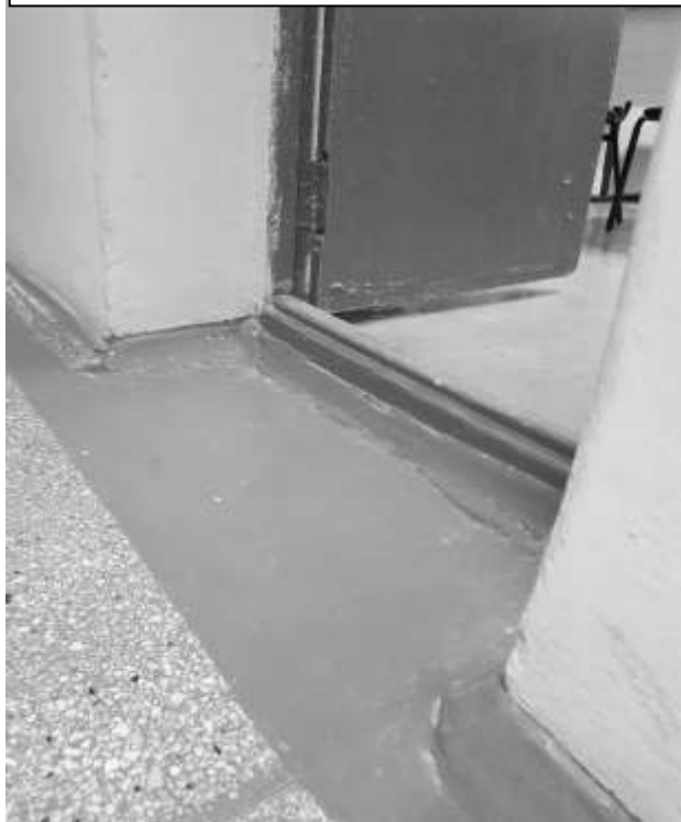
Фото 14 – Вход в учебную комнату I этаж
