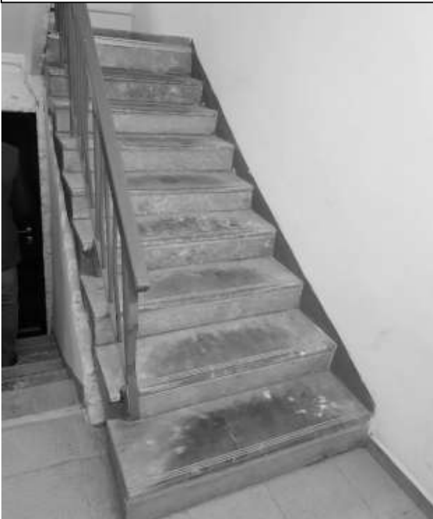
Фото 37 – Лестница на верхние этажи
