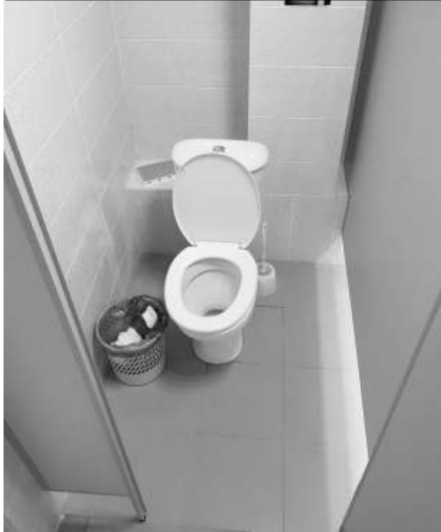
Фото 64 – Санузел IV этаж
