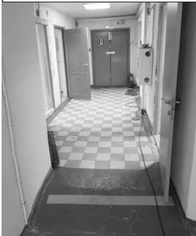
Фото 66 – Коридор IV этаж
