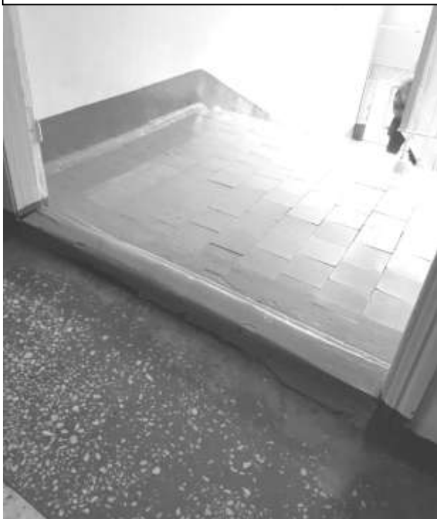
Фото 69 – Вход в столовую
