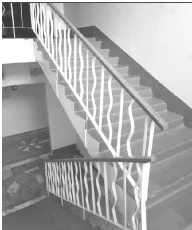
Фото 67 – Лестница на II этаж
