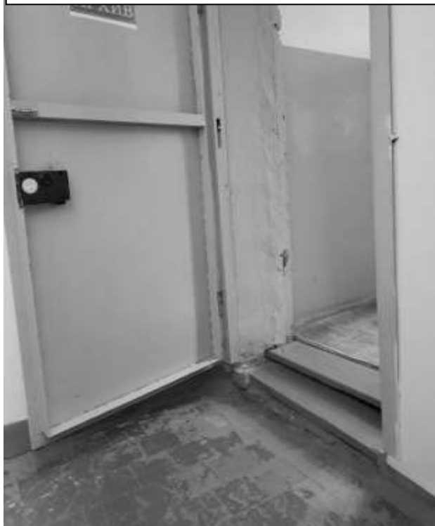
Фото 30 – Запасной выход из актового зала
