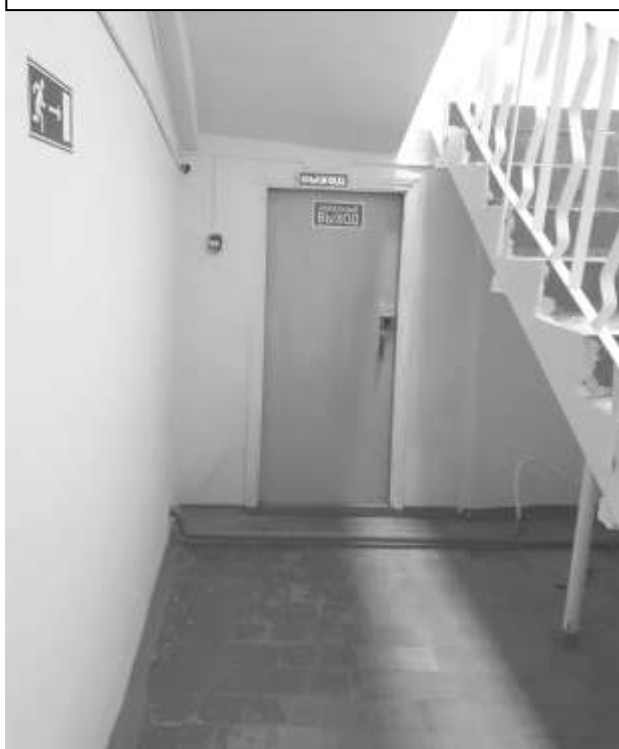
Фото 31 – Запасной выход из актового зала
