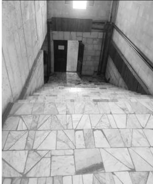
Фото 20 – Вход в актовый зал
