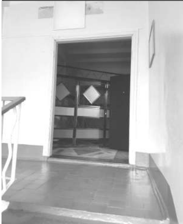
Фото 68 – Вход в столовую
