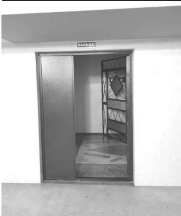
Фото 72 – Вход в столовую
