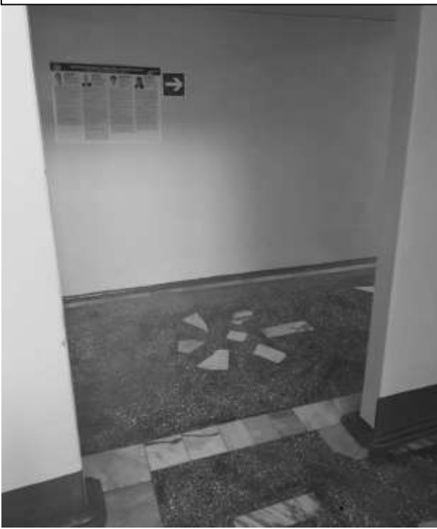
Фото 77 – Выход на I этаж
