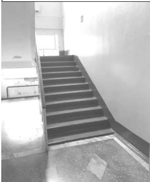
Фото 66 – Лестница на II этаж
