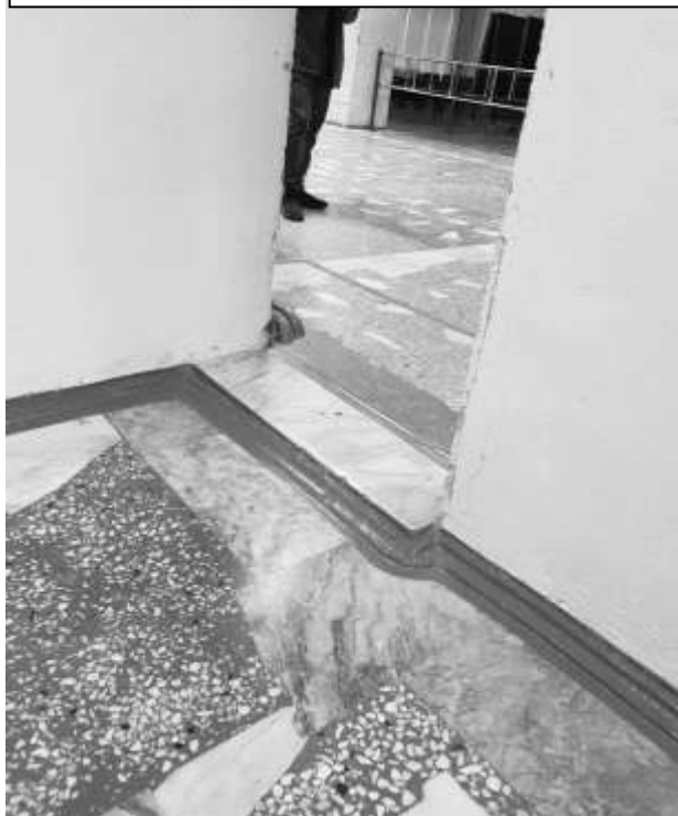
Фото 34 – Путь движения внутри здания
