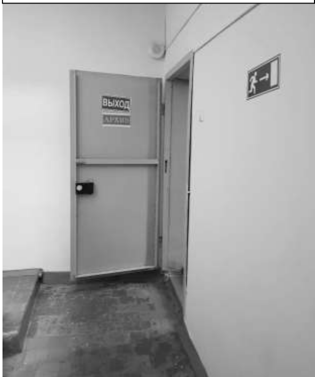
Фото 29 – Запасной выход из актового зала
