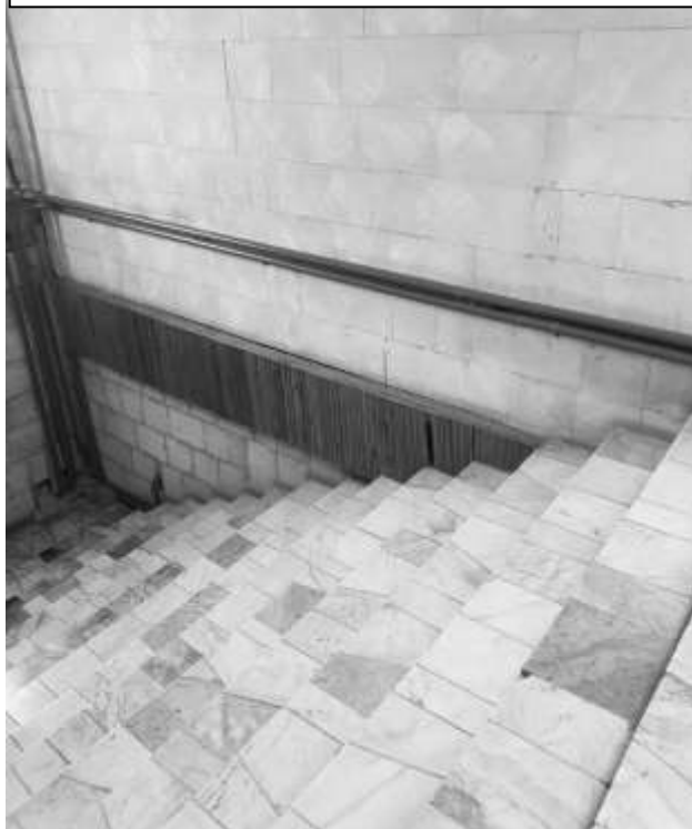
Фото 22 – Вход в актовый зал
