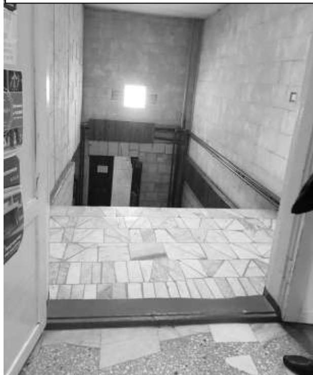
Фото 18 – Вход в актовый зал
