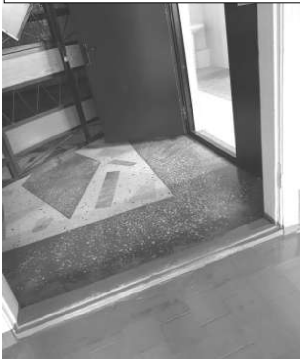
Фото 70 – Вход в столовую
