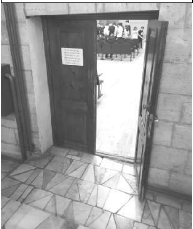
Фото 23 – Вход в актовый зал
